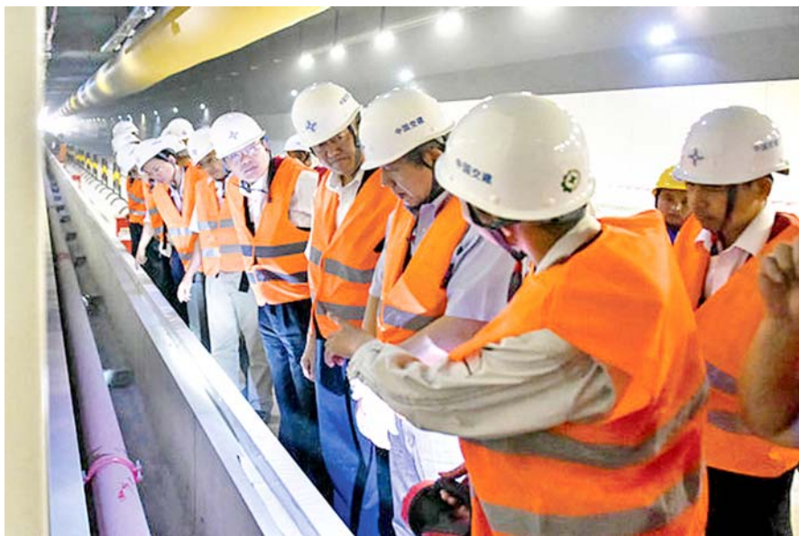
中心组在西人工岛施工现场实地考察
